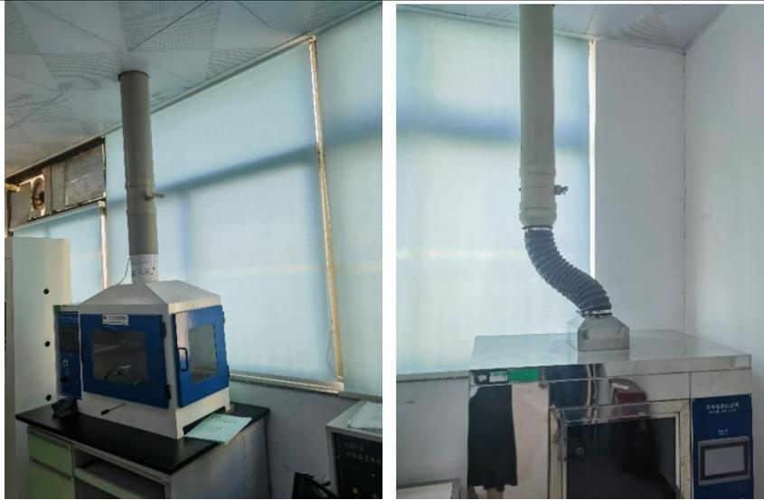
图 2-13 设备废气排口直连照片
