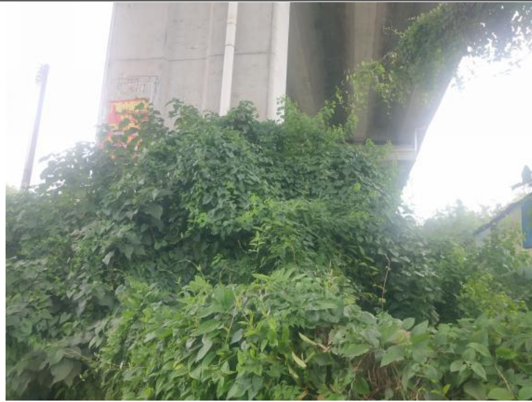
项目东南面：珠三角环线高速
