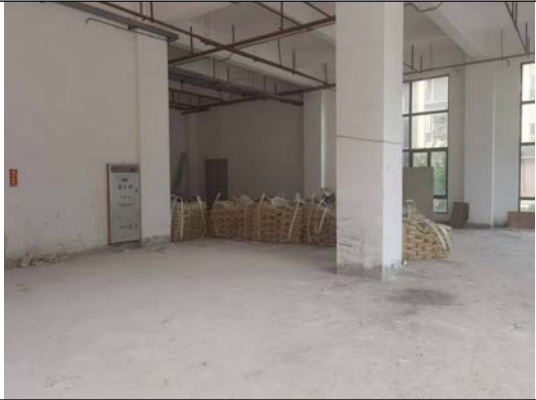
项目 A 栋中医院大楼内部
