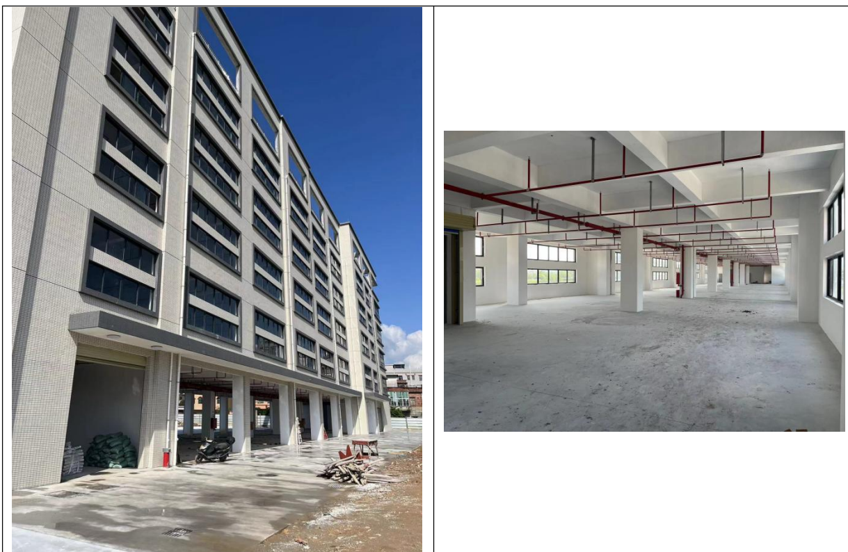
厂房内部现状照片
