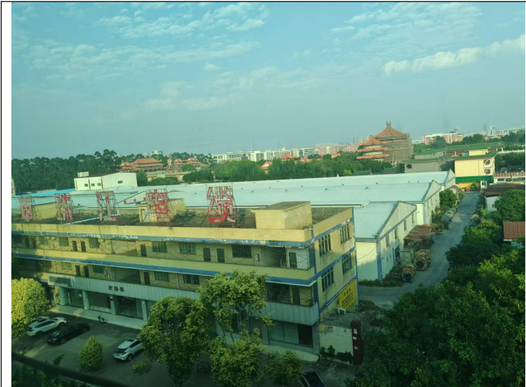
东面—广州环市珠江工业园区
