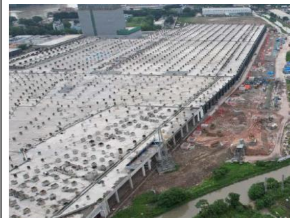
在建地铁十二号线车辆段用地
