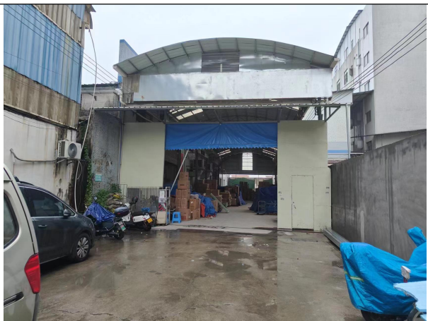
项目北侧厂房
