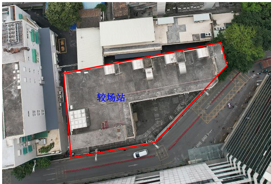
图 3-1 110 千伏较场站四周现状
