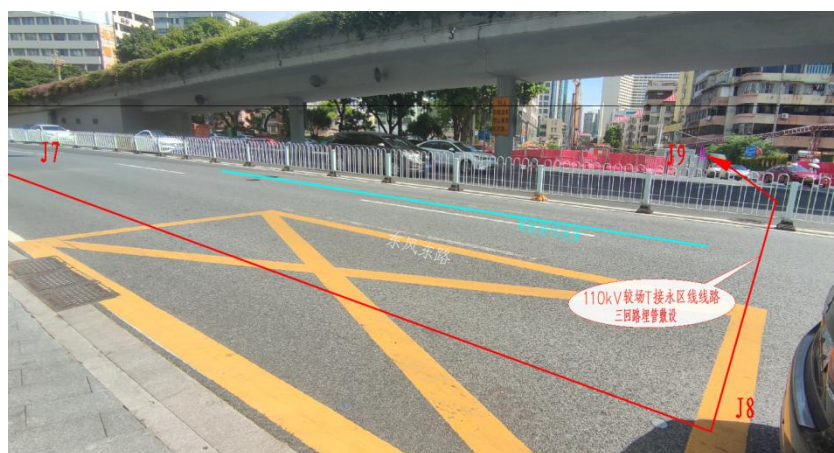
图 3-4 东风东路段敷设情况
