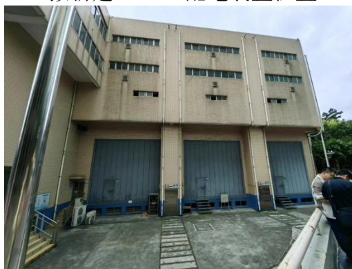
110kV 较场站配电装置楼
