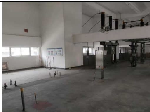
拟新建 110kV 配电装置位置
