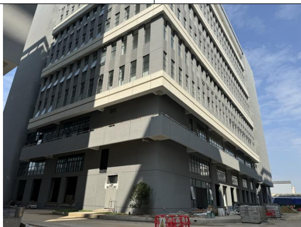
项目所在建筑物（园区 1#厂房）
