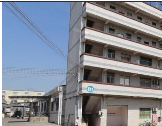
项目北面（大朗村第十四社工业区宿舍楼）
