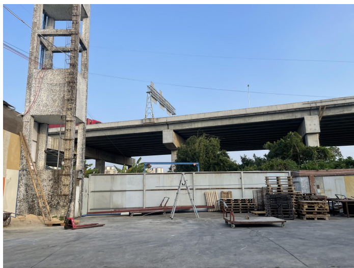
项目东面（空地）
