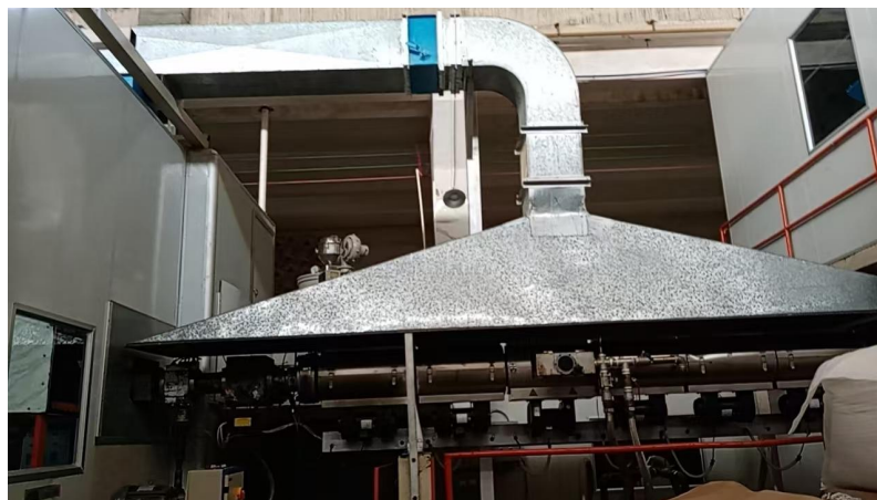
挤出成型机上方集气罩
