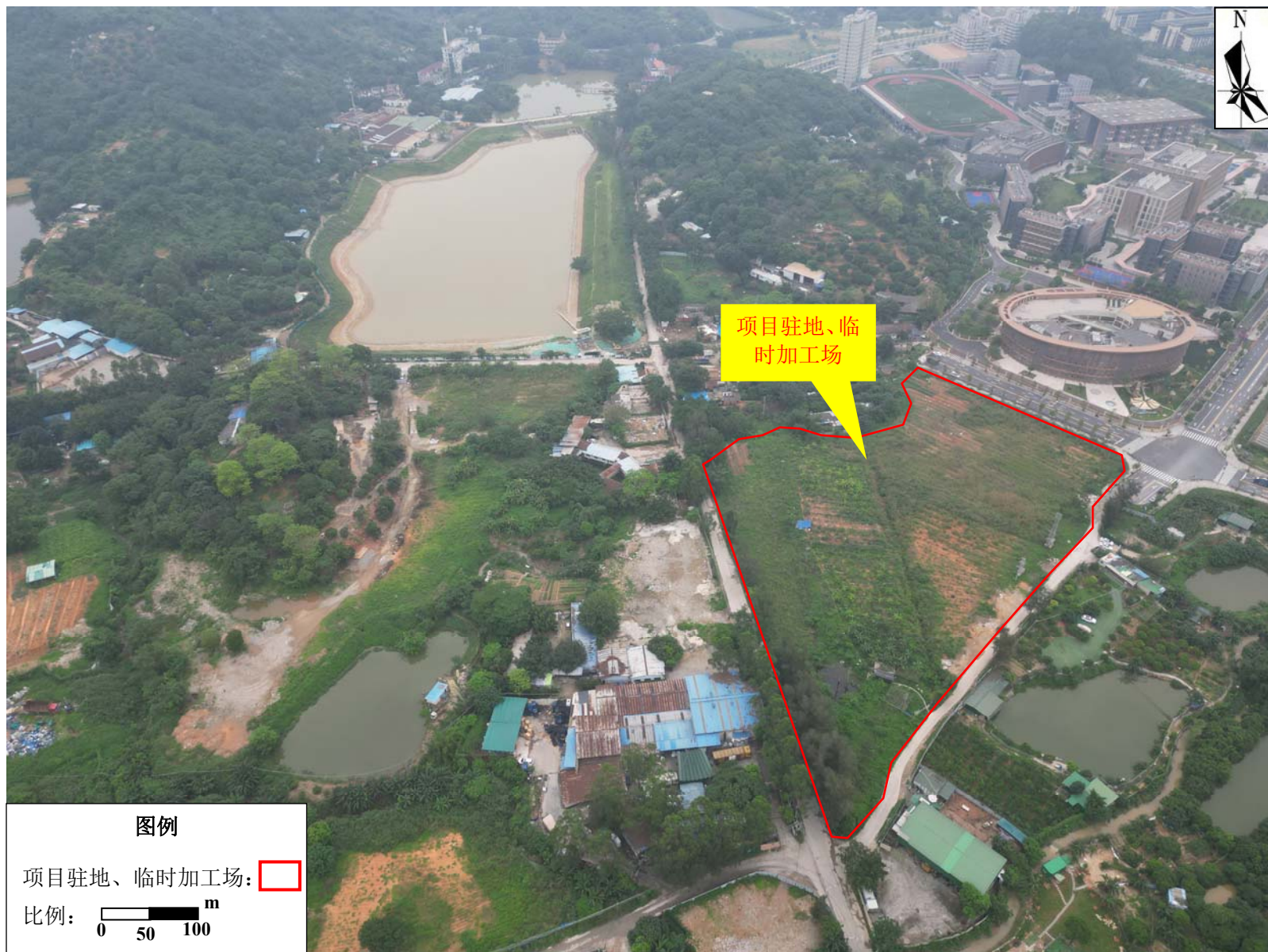
图 3.2-5 项目驻地、临时加工场现状图
