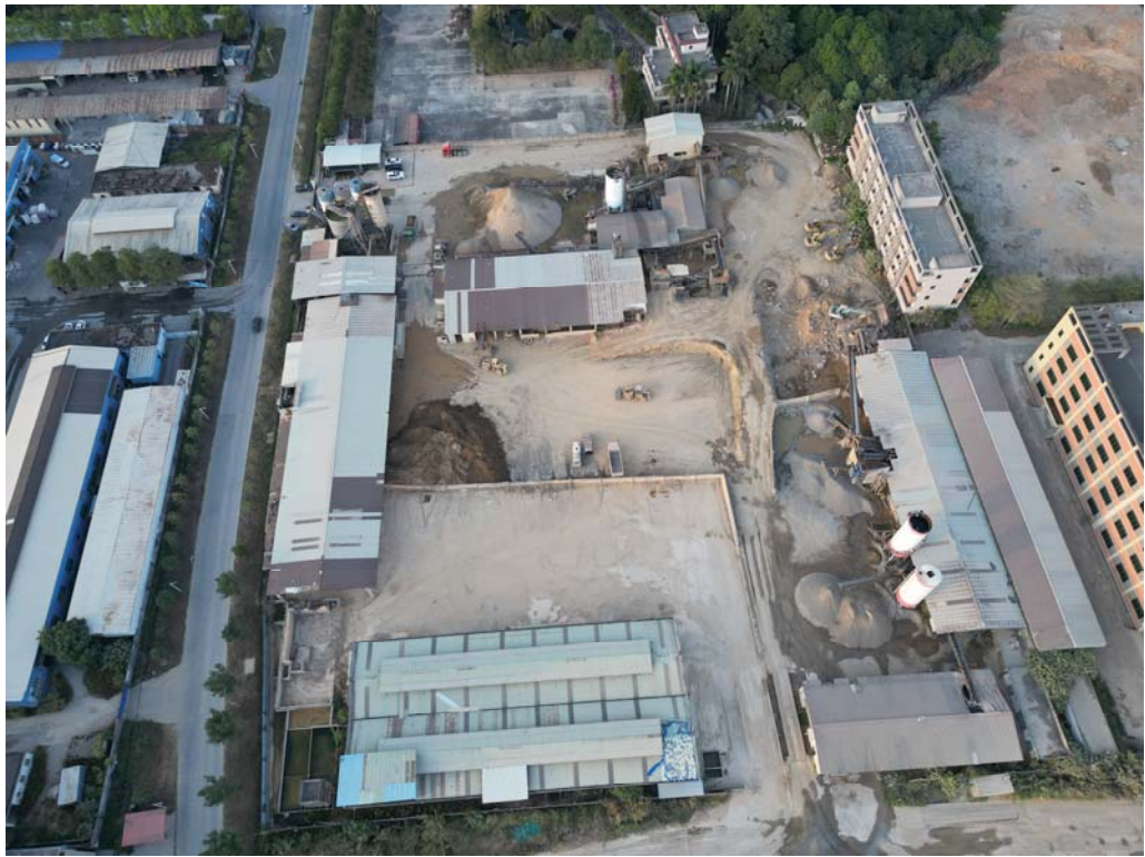
图 3.2-1 广州市潮穗再生资源有限公司弃土消纳地现场照片
