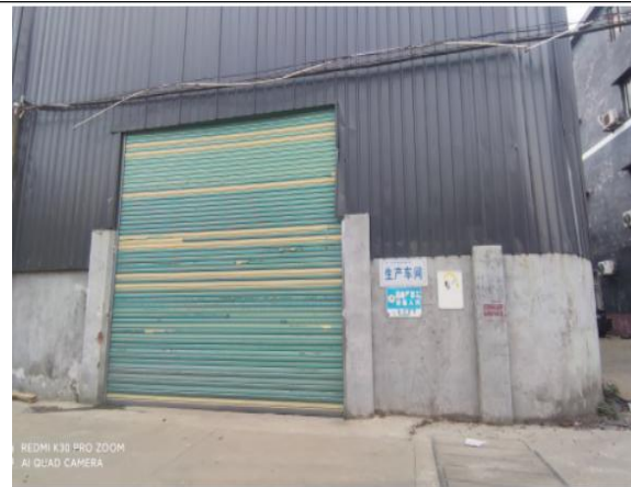
项目西面-空厂房
