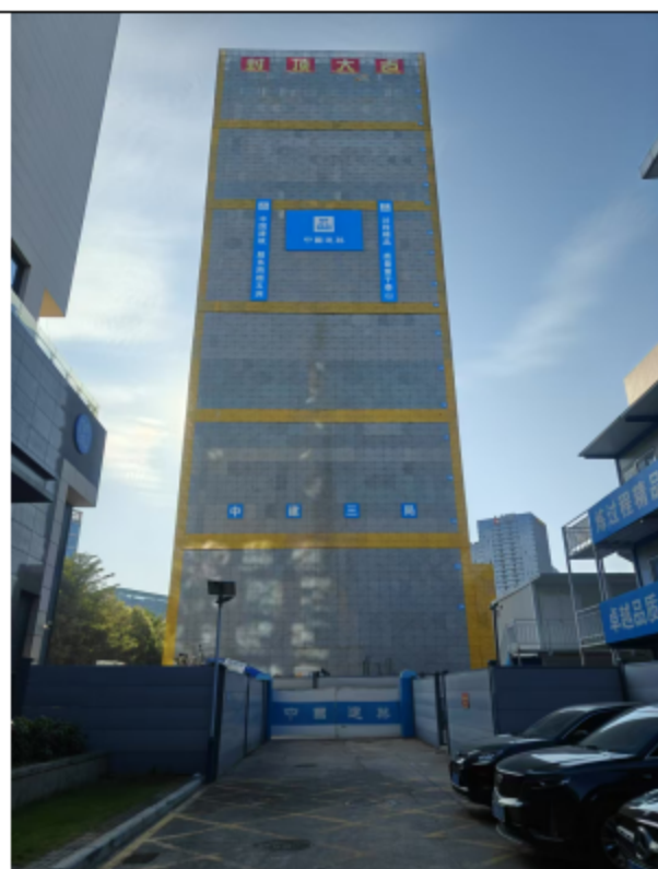
项目所在建筑整体情况 目前在建
