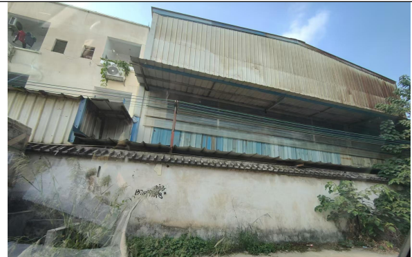
项目西北侧-宏创（广州）精密制造有限公司
