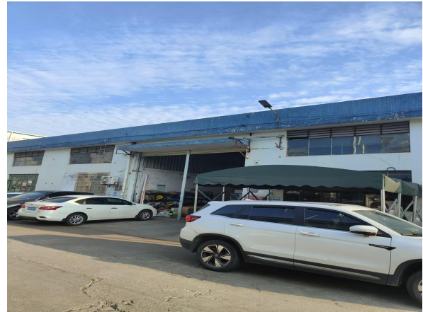
项目东侧振兴线切割
