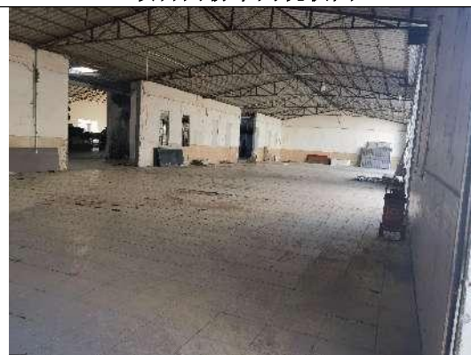
项目综合车间现状图
