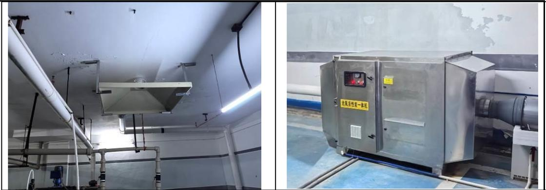
图 2-6 污水处理间废气处理设施照片
