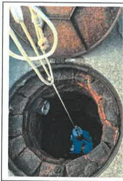
生活污水排放口 W1
