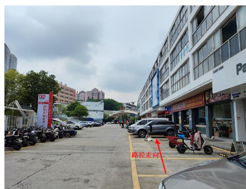
本工程电缆线路沿线（天健家居装饰广场内道路，采用埋管及电缆沟敷设）
