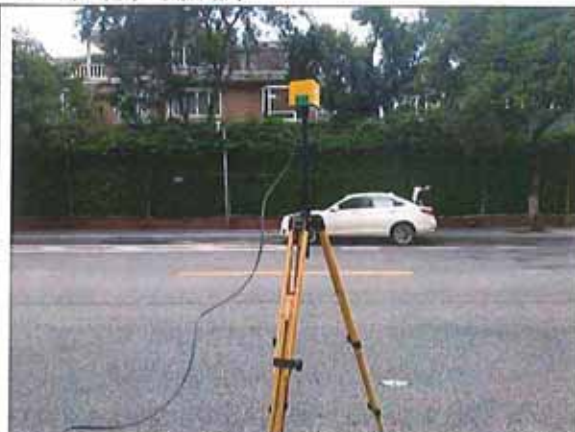
Pic1 电力隧道检测断面
