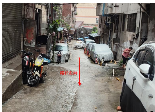
本工程电缆线路沿线（蟾蜍石北巷，采用埋管及电缆沟敷设）
