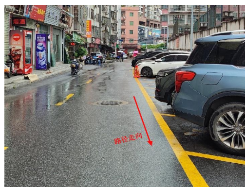
本工程电缆线路沿线（白水塘北街，采用埋管及电缆沟敷设）
