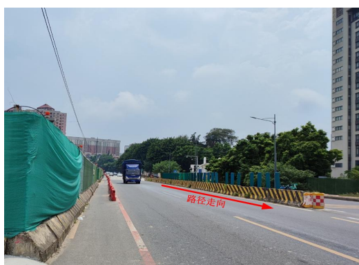
本工程电缆线路沿线（沙太北路，采用顶管及电力隧道敷设）
