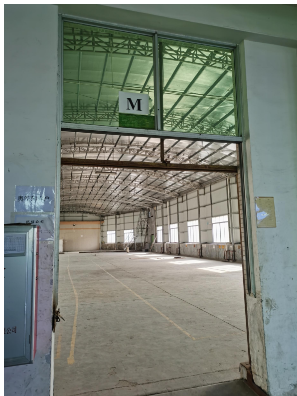
项目南侧闲置厂房
