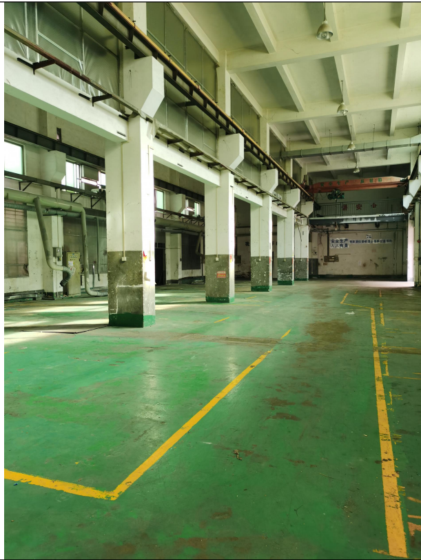
本项目厂房内现状
