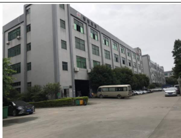
项目西南面-B7 栋
