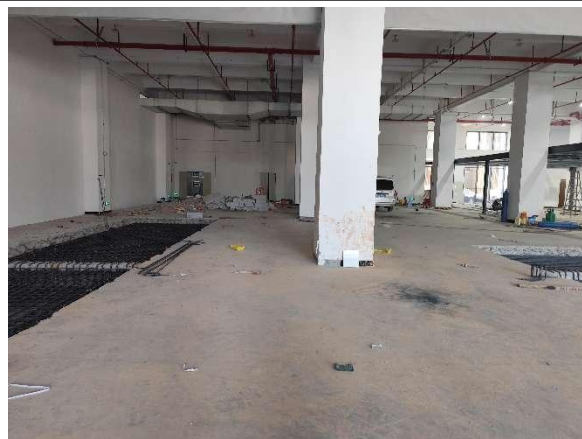
项目一楼现状
