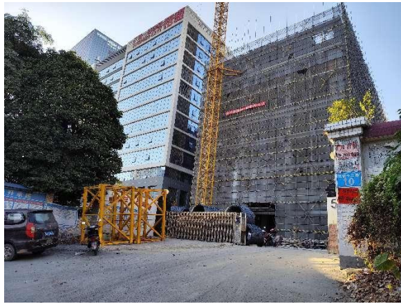
项目东面（4m）：园区内在建厂房
