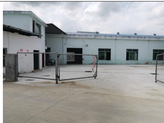
项目北面空置厂房
