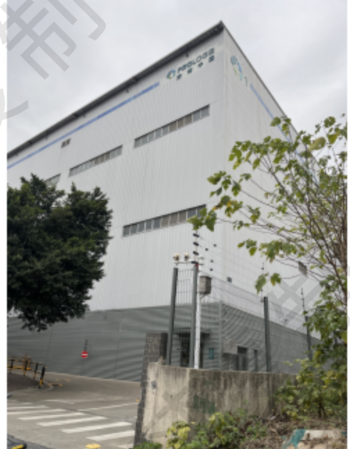
项目西面 安博广州开发区物流中心
