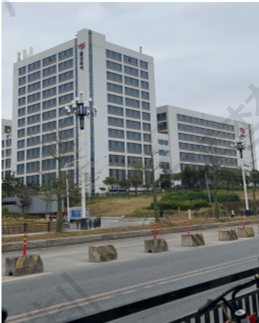
项目南面 隔东勤路为黄埔区通达电气
