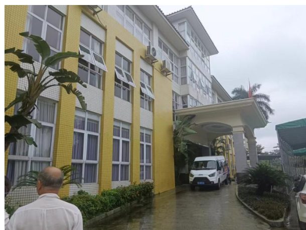
项目北面--园区办公楼
