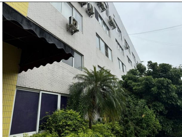
项目南面--园区内厂房
