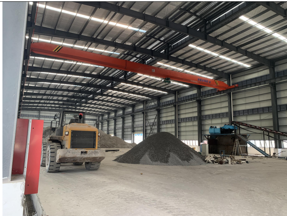
项目西面-广州西江鸿盛环保科技有限公司厂房（仓库）
