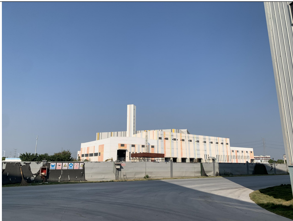
项目东面-厂区内道路
