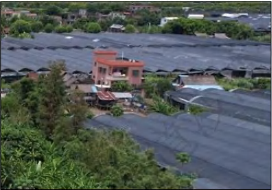
沙西街东侧居民住宅现状
