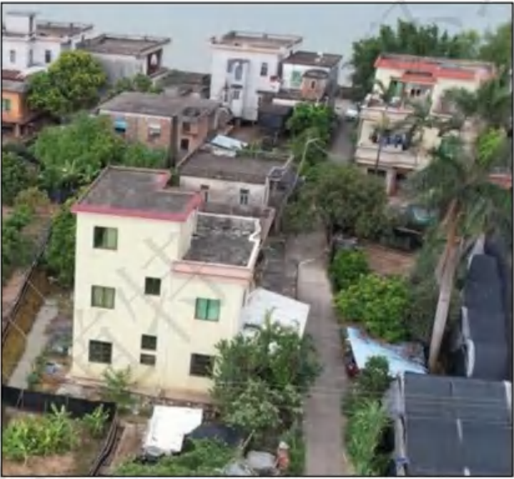
临道路侧建筑物现状
