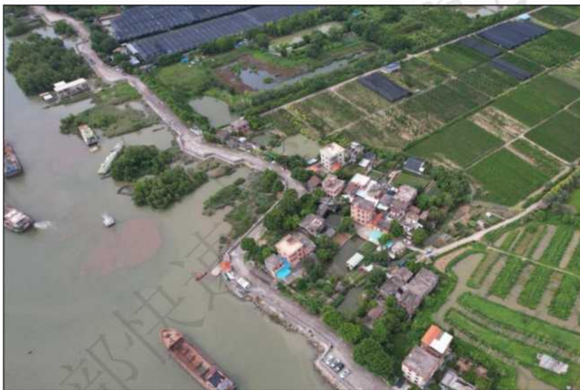
本项目跨越沙湾水道上游无瓣海桑现状照片
