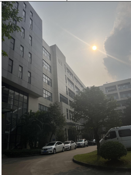
项目所在建筑（华新园 G5 栋）
