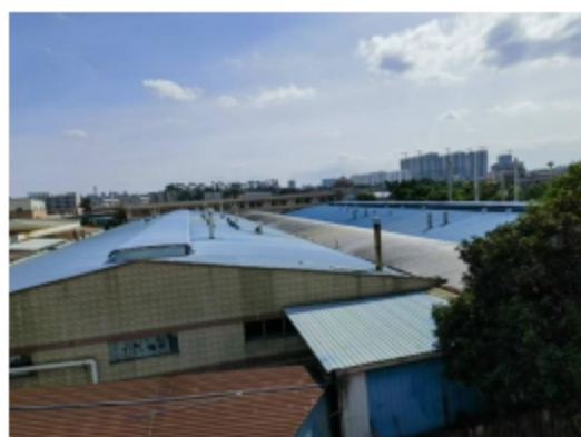
东面—广州扬昇机械有限公司
