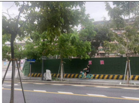
开拓一横路、在建工地、广钢观鹤小区
