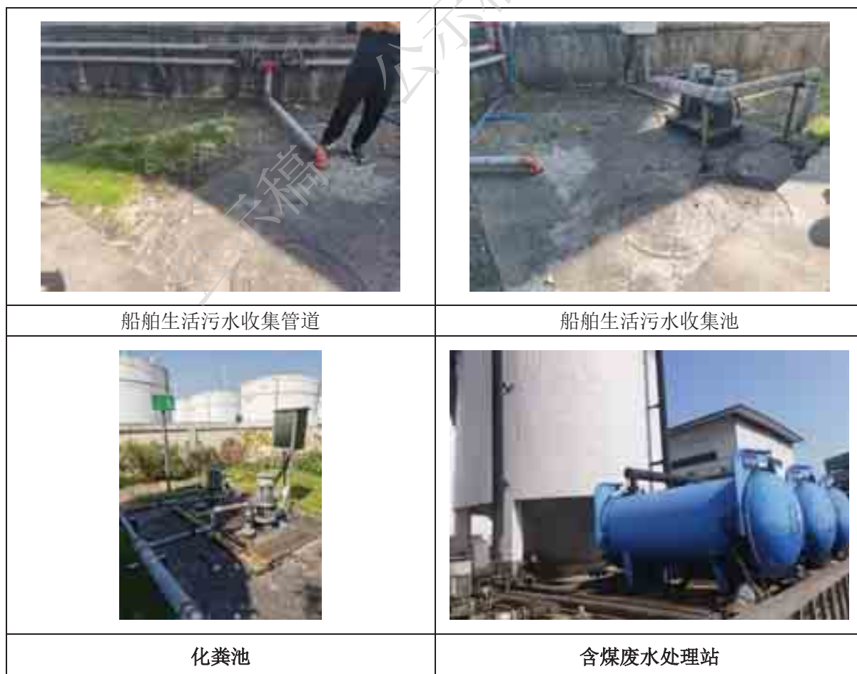
图 3.12-4 生活污水收集、治理设施现状照片
