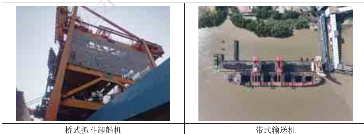
图 3.8-1 现有项目主要装卸设备现场照片
