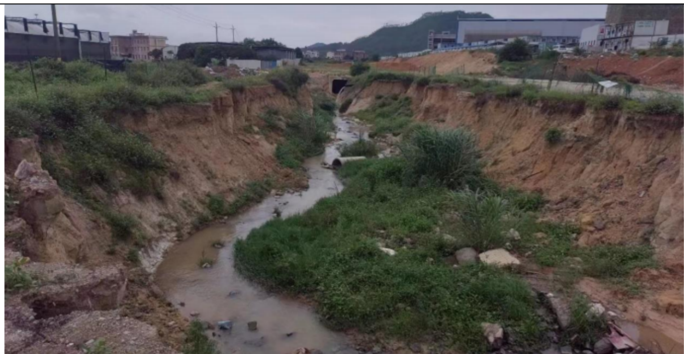
响水河玉湖地块剩余未实施段原河道现状
