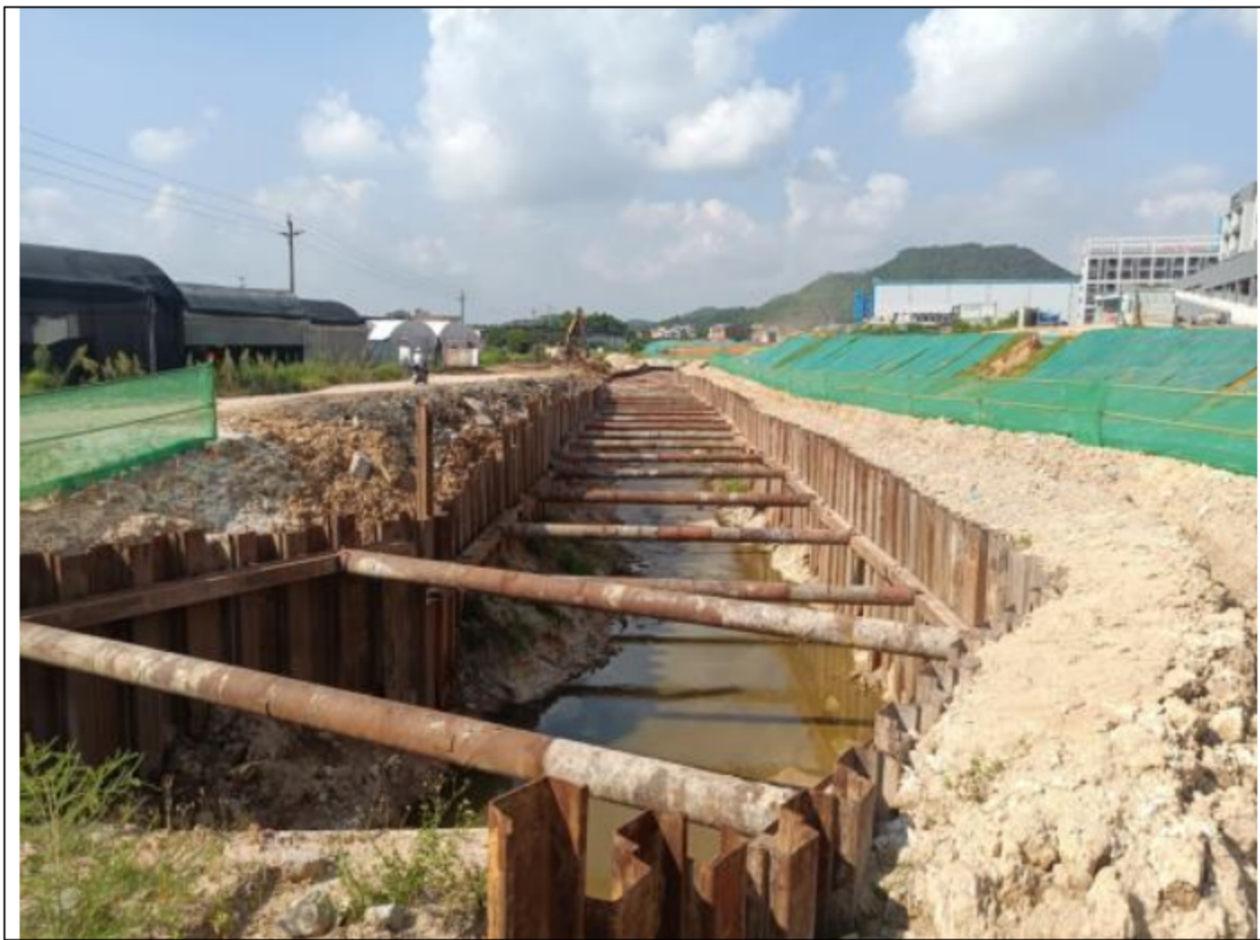
响水河玉湖地块剩余未实施段现状钢板桩临时支护
