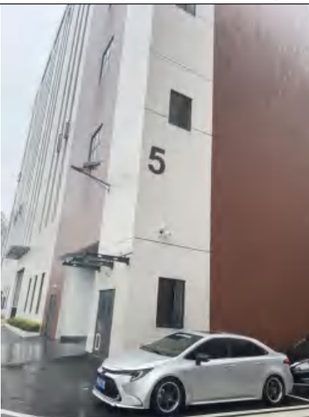
项目所在建筑物（5号楼）
