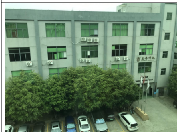
项目西北面-B10 栋
