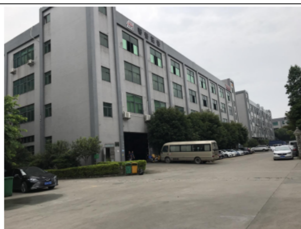
项目西南面-B7 栋
