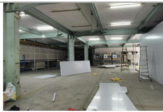
项目生产车间现状
