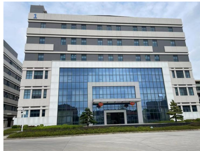
项目南面：园区厂房一
