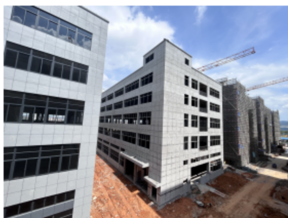
西面-在建厂房
