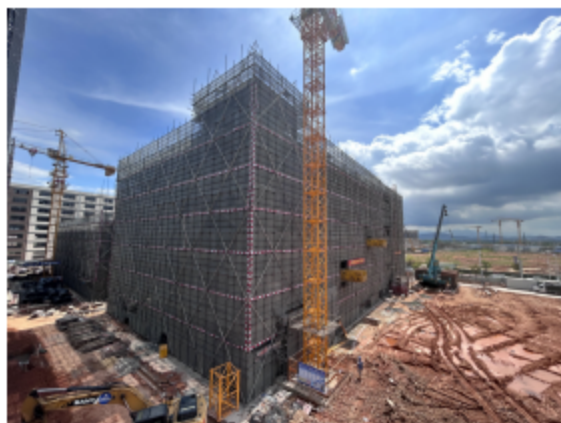
东面-在建厂房
