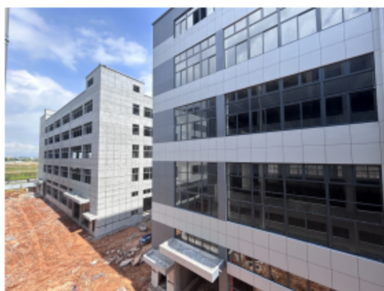
北面-在建厂房
