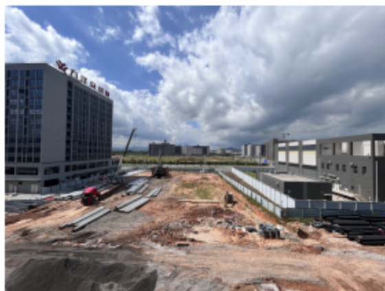
南面-在建厂房
