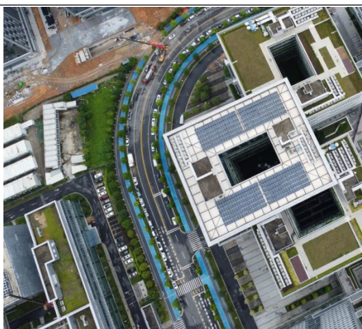
西面（园区道路）
