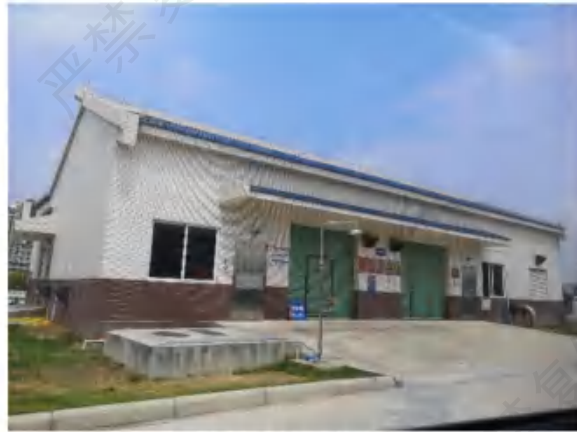
接触消毒池及加药间
