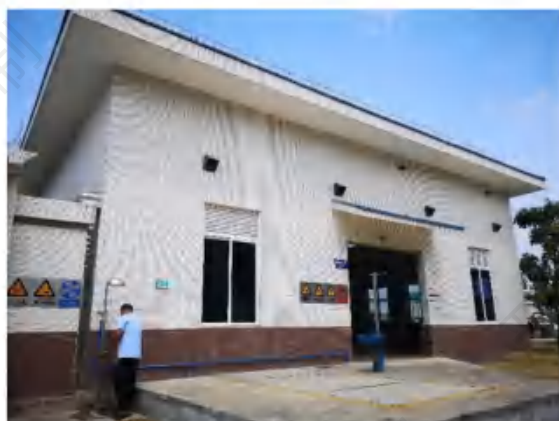
粗格栅及提升泵房
