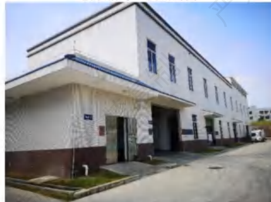
污泥干化车间
