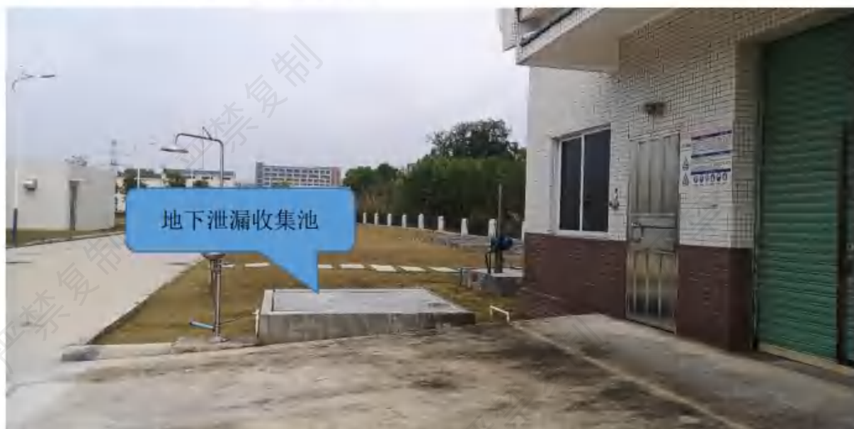
图 5.9.5-1 次氯酸钠消毒间外照片
