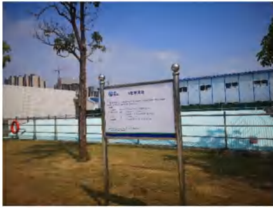
高密度沉淀池及砂滤池
