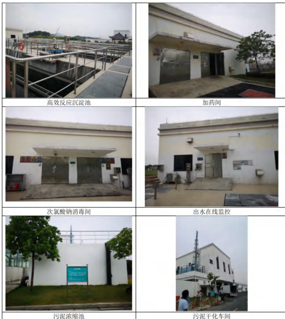
图 2.1.4-1 厂区现有主要构筑物照片
