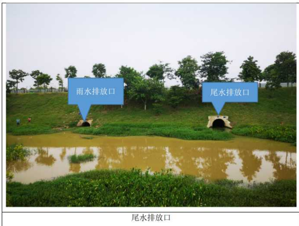
图 2.1.2-1 九龙水质净化一厂四至实拍照片
