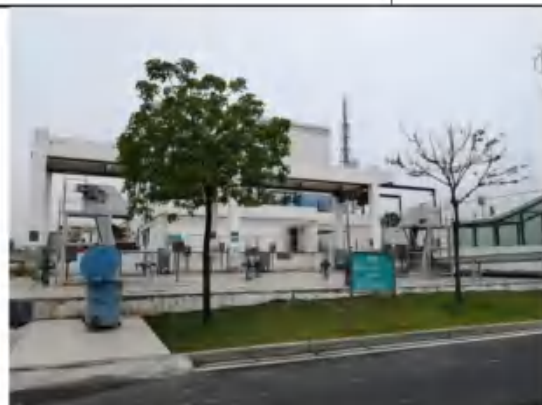
粗格栅及提升泵房 (背后是细格栅及曝气沉砂池)
